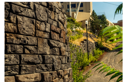
Budowanie bliżej linii podziału
