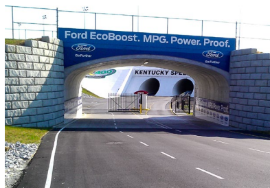
Stützen von Brücken
